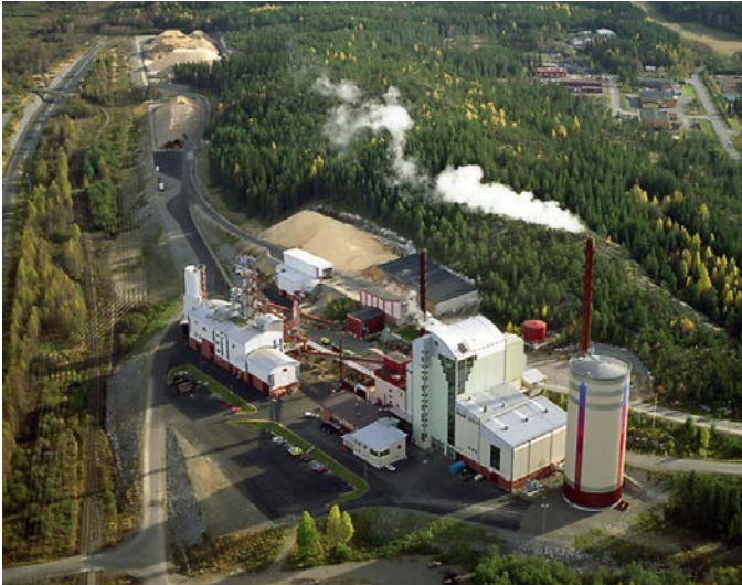
Pic1. The bioenergy combine in Hedensbyn, Skellefteå.
